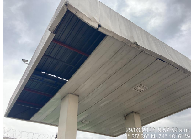
Foto 24. Canopy parcialmente desmantelado
