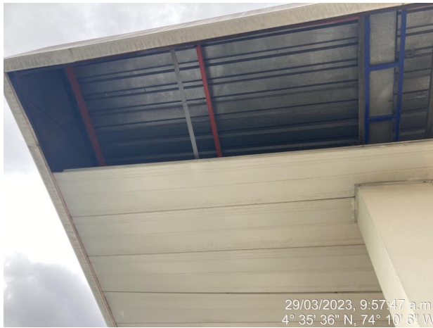
Foto 25. Canopy parcialmente desmantelado
