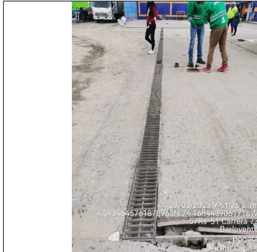
Foto 15. Rejilla perimetral y piso del predio
